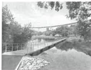
Imagem 6 - Travessia do Corgo – Ponte flutuante
