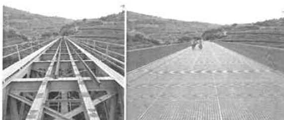
Imagem 9 - Ponte sobre o rio Tanha - Situação atual
